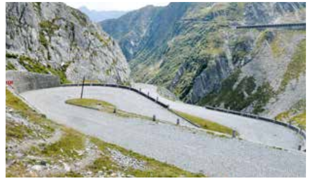
Die Tremolastrasse wurde in den Jahren 1827 – 1830 erbaut und war bis in die sechziger Jahre die einzige Fahrstrasse über den Gotthard-Pass. Die Strasse ist heute eine einzigartige Attraktion für Touristen und stellt das längste Strassenbau-Denkmal der Schweiz dar.
